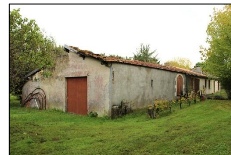
Maison de vigneron avec chais à St-Vivien-de-Médoc
