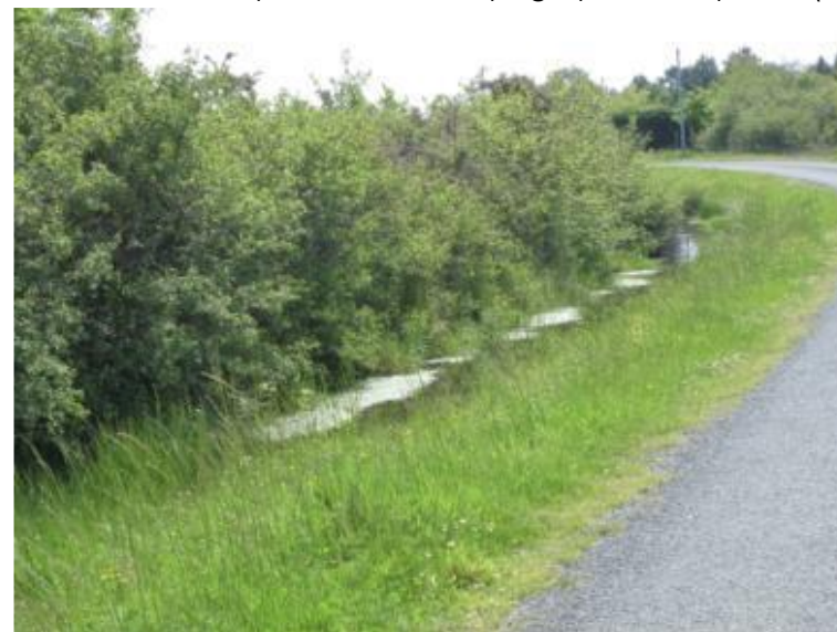
Fossé dans le secteur de palus à Talais
