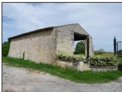
Corps de ferme à St-Vivien-de-Médoc
