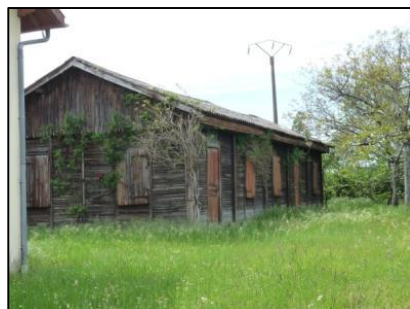
Abri en bois à proximité du centre bourg de St-Vivien-de-Médoc
